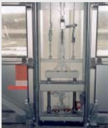
Vista interna del montante centrale in condizione bloccata, portone chiuso
