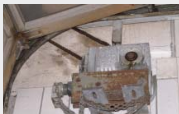
Albero portamolla e motore con rinvio a catena montato anteriormente
