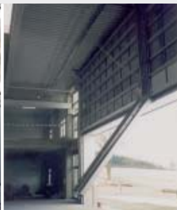
Portone aperto, montante centrale sbloccato e in fase di apertura
