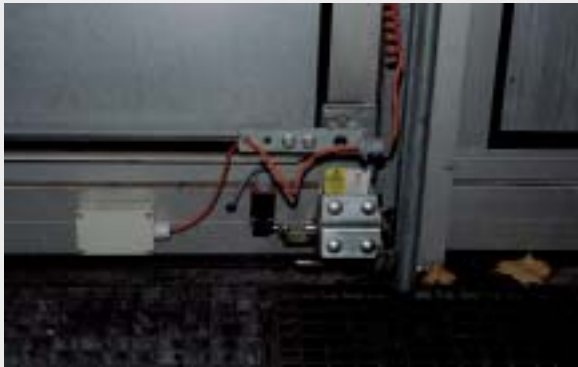
Blocco angolare in acciaio inossidabile con scatola di connessione IP 65
